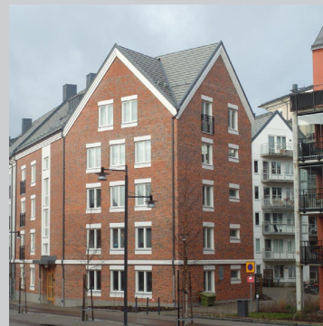
Kv Pilgrimen, fasad mot S Järnvägsgatan
