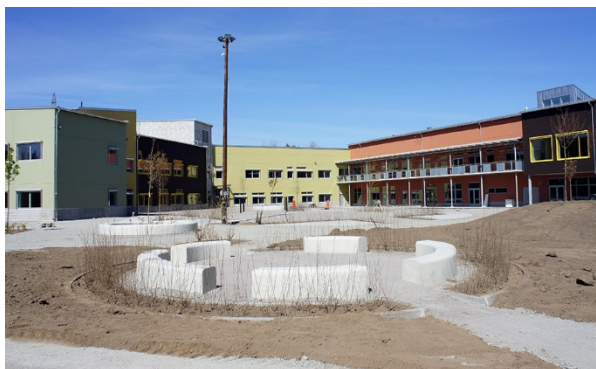
Arbetet med att färdigställa utemiljön pågår.
