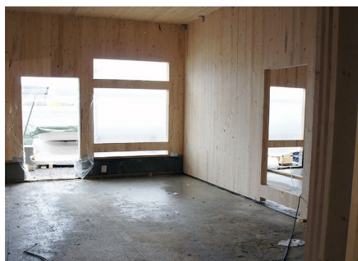
Förskolan (täckt) med matsal är på plats. Förskolans stomme är i massivt trä.
