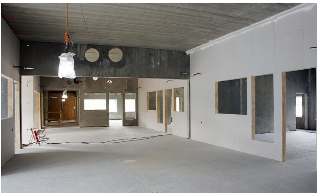
I stora delar av byggnaden arbetats det för fullt med innerväggar och installationer. Entré- och högstadietdelen är den del där det finns mest kvar att göra.
