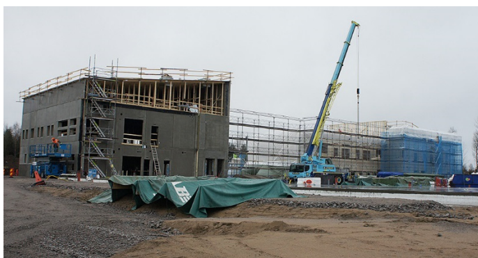
Förskolan (täckt) med matsal är på plats. Förskolans stomme är i massivt trä.
